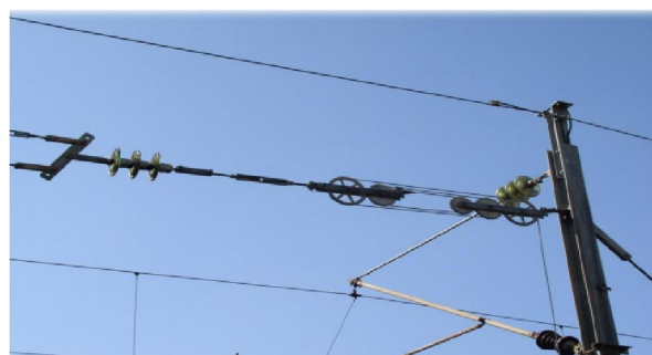
Fig.30.b Appareil tendeur à moufles avec poulies à axes parallèles
