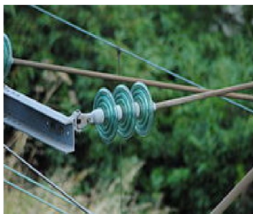
Fig.28.a. Isolateur synthétique
